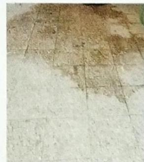
Foto 6: Empozamiento de agua pluvial.
