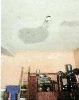
Foto1: Filtración de agua en el techo de las aulas
