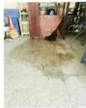
Foto 2: Empozamiento de de agua en el piso de las aulas debido a la filtración que se da en el techo de las mismas.
