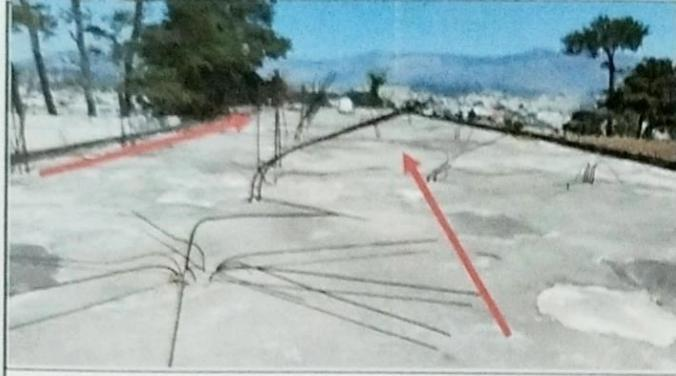
Foto 1: Área que muestra el estado actual del techo de losa en las aulas
