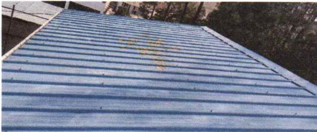
Sustitución de lámina por lámina troquelada calibre 26
