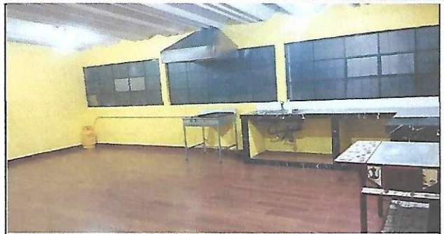
Foto 2: Vista e instalación, piso cerámico en cocina finalizada.
