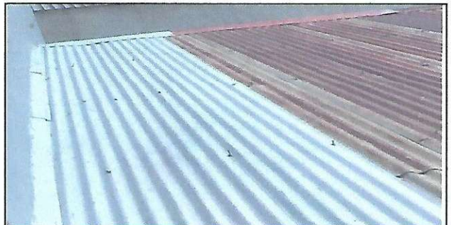
Foto 6: Vista e instalada de lámina calibre 26.
