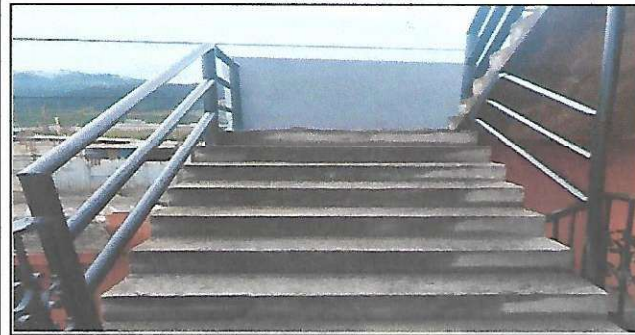
Foto 3: Vista de instalación de barandas finalizadas.
