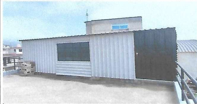
Foto 1: Vista de instalación de puerta y ventana finalizada.
