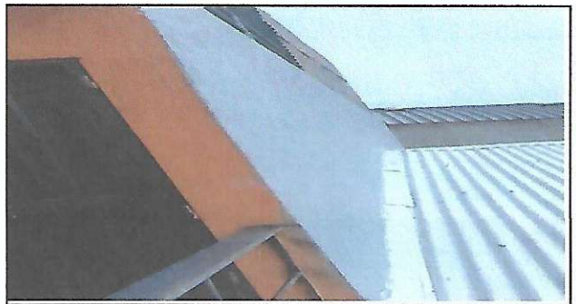
Foto 4: Vista final de aplicación de repeo e impermeabilización exterior.
