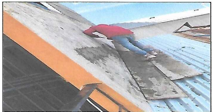
Foto 4: Aplicación de repero e impermeabilización exterior.
