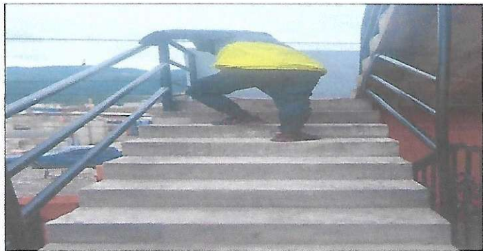
Foto 3: Instalación de barandas para gradas.
