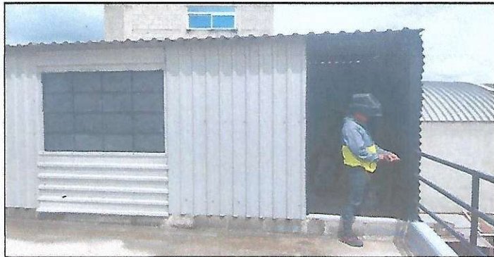
Foto1: Instalación de puerta y ventana
