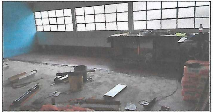
Foto 2: Instalación piso cerámico en cosina.
