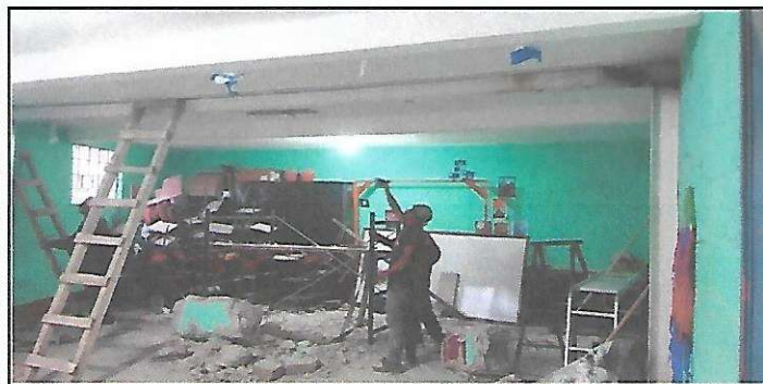
Foto 5: Demolición de columna de estructura de concreto.
