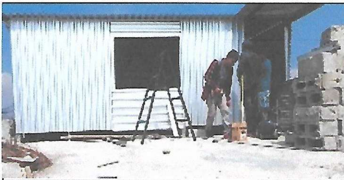
Foto1: Suministro e Instalación de puerta y ventana.
