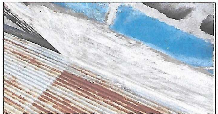
Foto 4: Suministro y aplicación de repero e impermeabilización exterior
