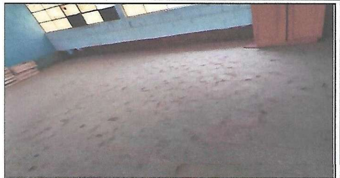
Foto 2: Sustitucion e Instalación piso cerámico en cosina.
