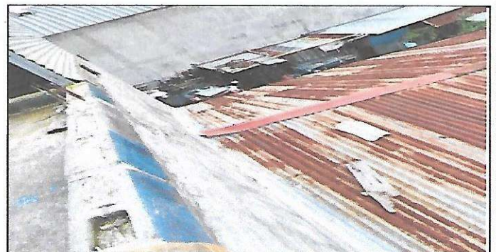
Foto 6: Sustitución e instalación de lámina calibre 26.
