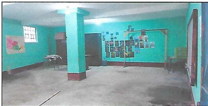
Foto 5: Mantenimiento de estructura de concreto.
