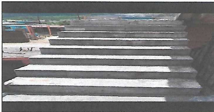
Foto 3: Suministro e instalación de barandas para gradas.
