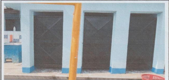
Foto 6: MANTENIMIENTO DE DRENAJE
