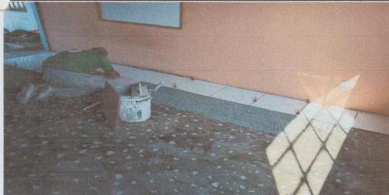
Foto 5: COLOCACIÓN DE PISO EN AULAS
