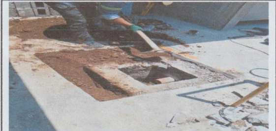
Foto 4: MANTENIMIENTO DE SISTEMA DE DRENAJE
