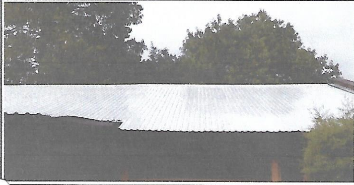
Sustitución de lámina duralita, por lamina troquelada calibre No.26 en el taller de Automotriz
