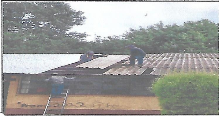
Sustitución de lámina duralita, por lamina troquelada calibre No.26 en el taller de Automotriz
