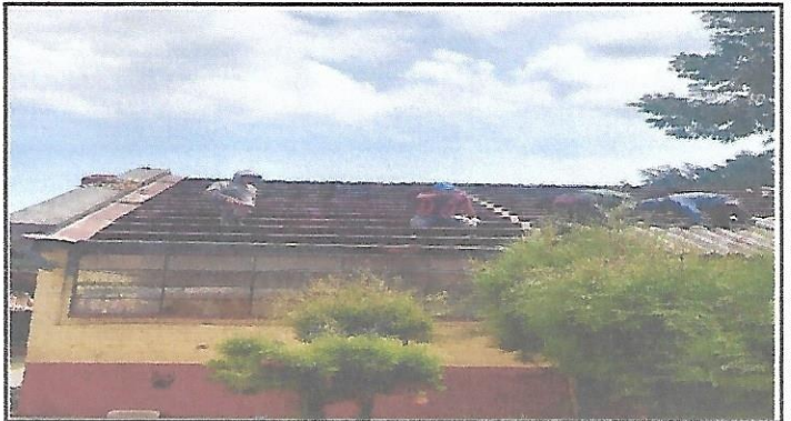
Sustitución de lámina duralita, por lámina troquelada calibre No.26 en el taller de Electricidad
