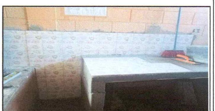
FOTO6: SUMINISTRO E INSTALACIÓN DE AZULEJOS Y MESA DE CONCRETO
