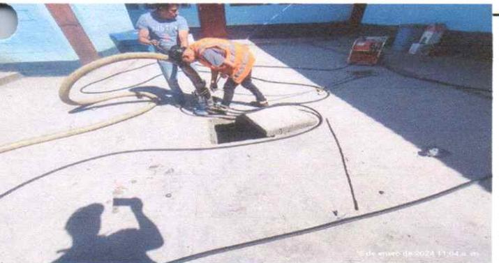
FOTO 5: ABSORCIÓN DE LODOS EN FOSA SÉPTICA NO, 2
