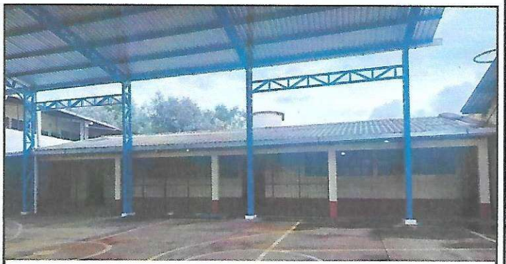
Foto 4: Vista lateral del techado hacia las aulas del segundo módulo.
