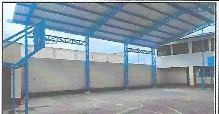
Foto 2: Vista desde la entrada principal a la cancha de baloncesto.
