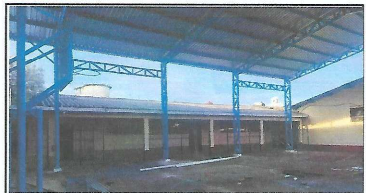
Foto 4: Armado de la estructura metálica aérea y colocación de lámina.
