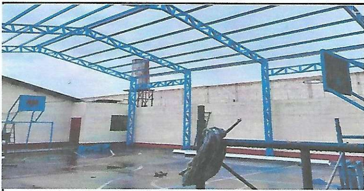
Foto 3: Colocación de estructura metálica que servirá de soporte del techado.
