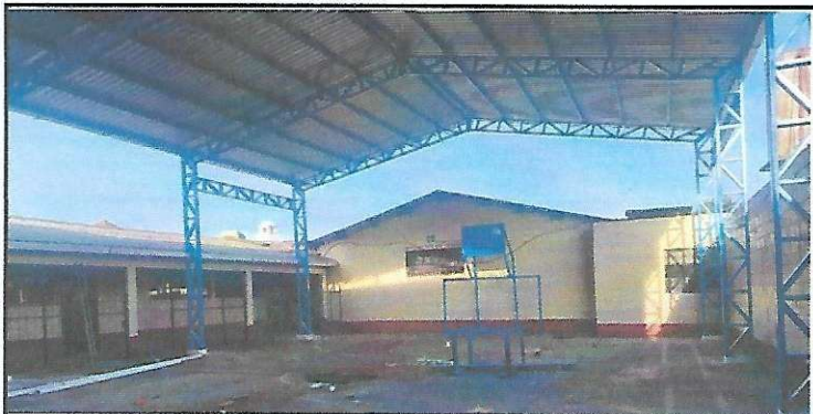
Foto 5: Colocación de techo de la cancha
