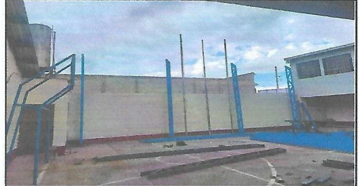
Foto 2: Pintura de los perfiles y estructura. Ensamblado de los primeros perfiles que servirán de columnas.
