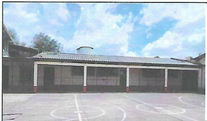
Foto 4. Vista lateral hacia las aulas del segundo modulo.
