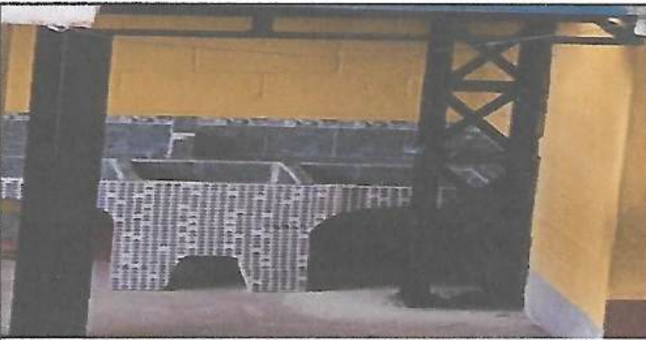
foto 3 terminadas la construcción de Joist donde sostiene la cocina
