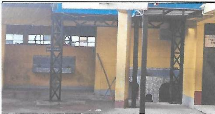
foto 4 obra de concluida de vigas y columnas del soporte de la cocina
