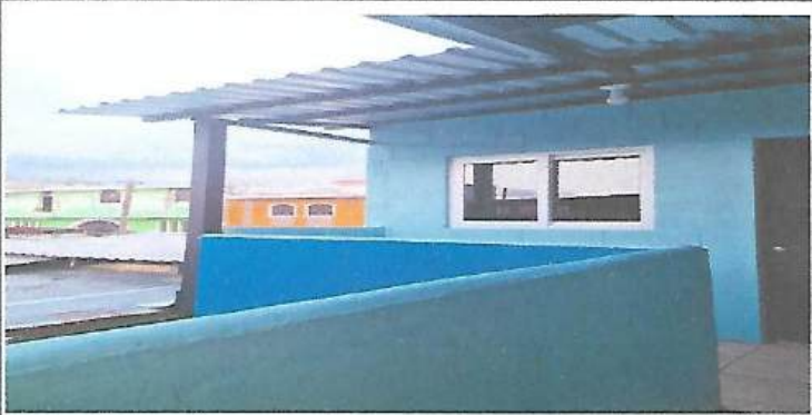
Foto 1 el remozamiento de cocina concluida
