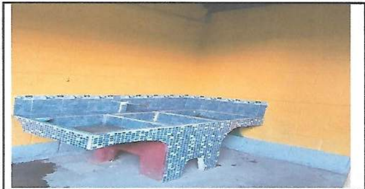
Foto 3: FOTO PRECIO REMOZAMIENTO COCINA
