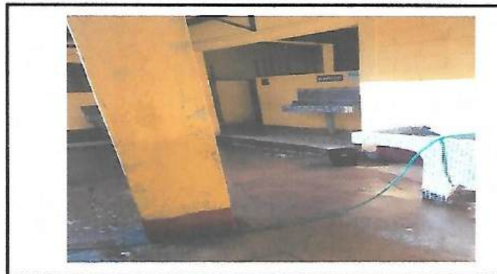
Foto 4: PREVIO DE REMOZAMIENTO COCINA
