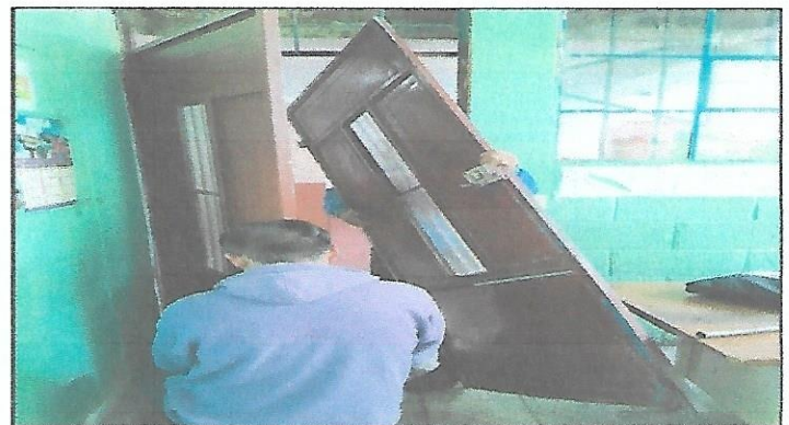
Durante: sustitución de puerta nueva por puerta antigua y deteriorada en la parte inferior
