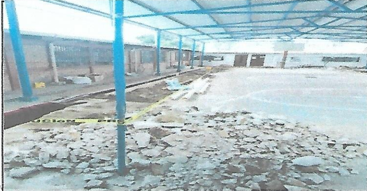
Durante :Introducción de tubería, para evitar que las las aguas pluviales no caigan en la cancha.
