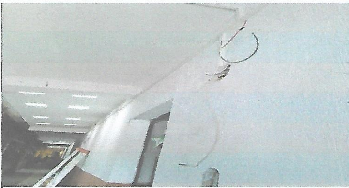
Durante: colocanco instalación eléctrica en pasillo
