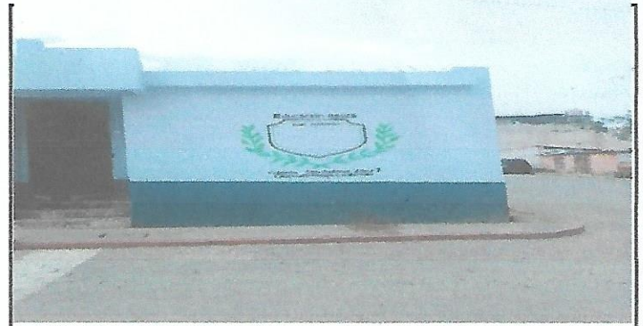
Durante: Fachada en Proceso de pintura de escudo del instituto.
