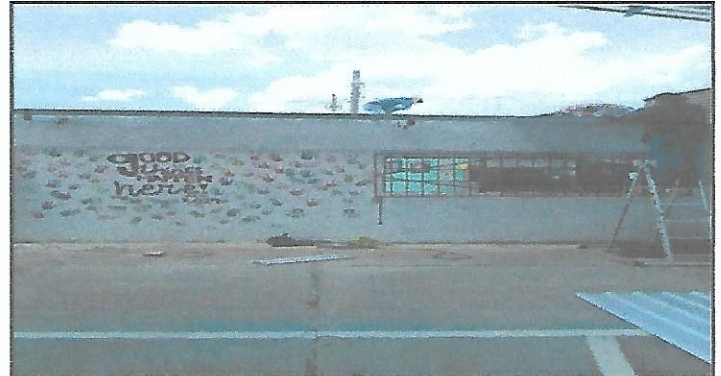
Durante: colocación de estructura metálica y láminas en aulas
