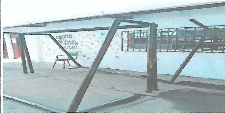
Previo: porteria con estructura dañada, despegada de sus partes.
