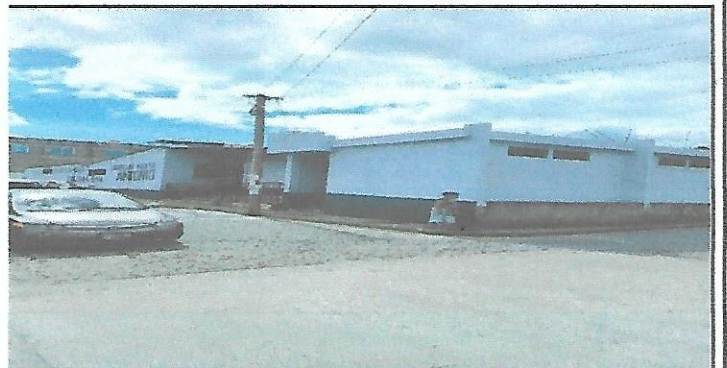
Previo: Fachada del instituto sin identificación, falta el escudo.
