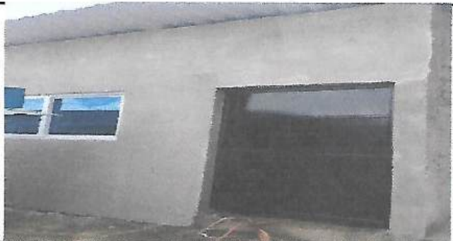
Foto 3: Suministro de ventanas y puertas
