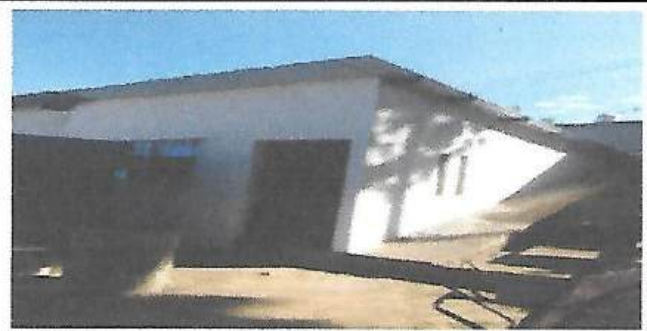
Foto 2: Suministro de techado y servicios eléctricos
