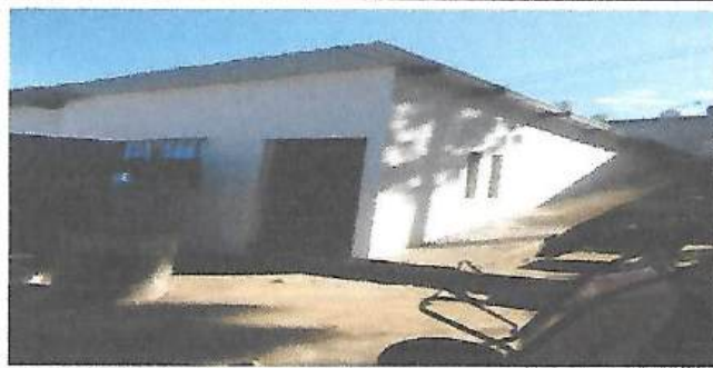
Foto 1: Área finalizada de Salón destinado a Dirección
