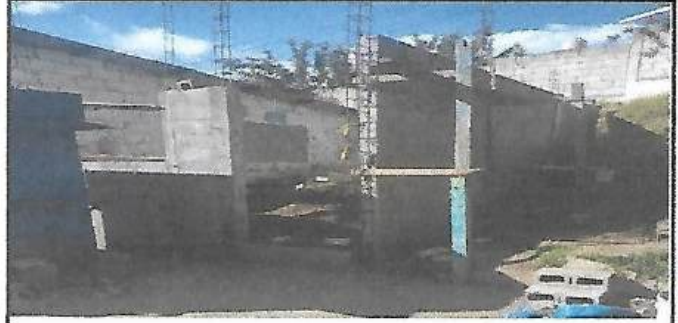
Foto 2: Implementación de muros del módulo
