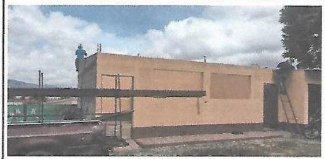
Foto 4: Instalación de entechado
