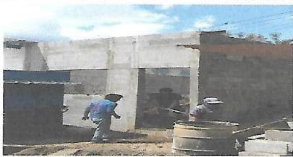
Foto 3: Levantado de muros
