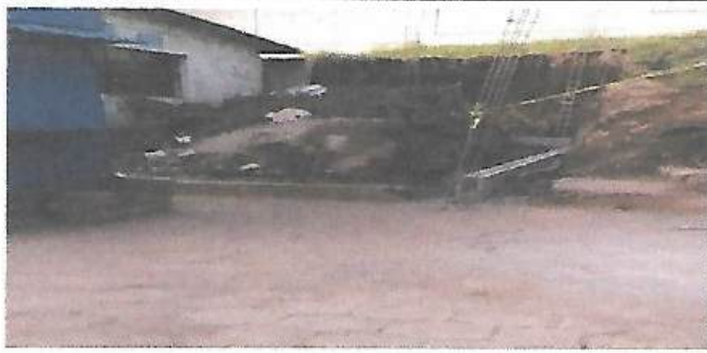
Foto 1: Cimentación del área, módulo destinado a Dirección
