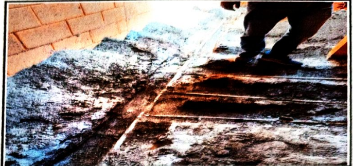
Cambio de tuberías dañadas
