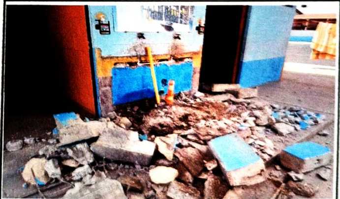
Retiro de pileta de lavado de manos
