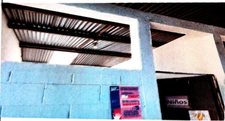
Intervención de ventanas en mal estado
