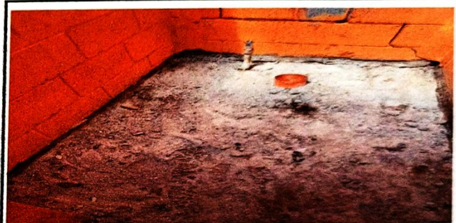
Retiro de sanitario en mal estado
