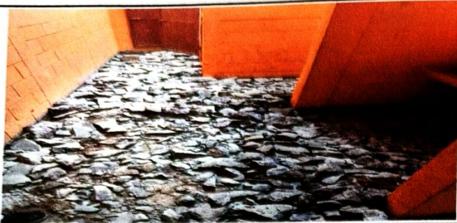
Retiro de piso en mal estado
