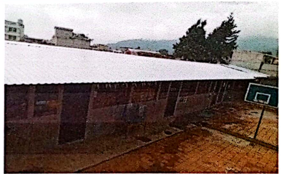
Foto 4: Vista frontal de la lámina nueva
