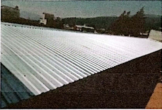
Foto 1: Vista de un caída de agua nueva
