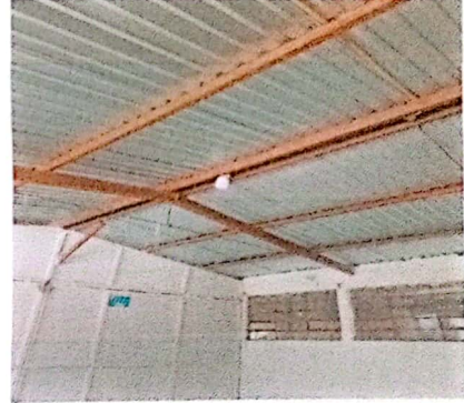
Foto 2: Interior de un salón
