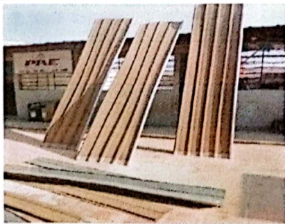
Foto 5: Trabajos de sustitución
