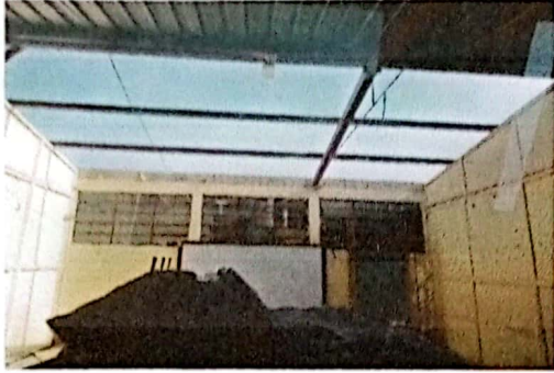
Foto1: Retiro de láminas viejas
