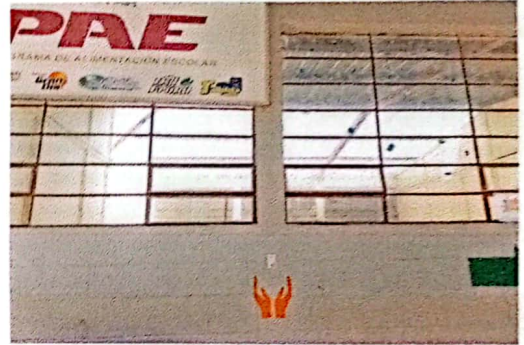
Foto 4: Retiro de láminas viejas
