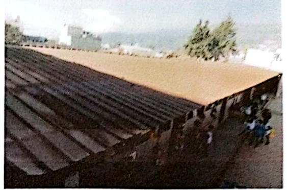
Foto 2: LÁMINAS OXIDADAS
