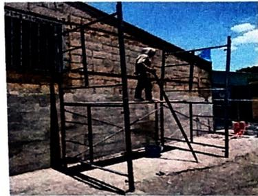
Aplicación de repello e impermeabilizante
