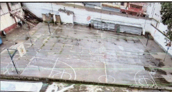
Foto 3: PAÑUELOS EN TERRAZA FINALIZADO
