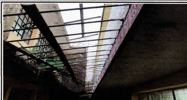
reparacion techo de pasillo sin lamina
