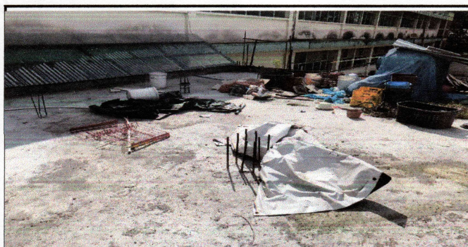
Suministro y reparacion de pañuelo de terraza para agua pluvial
