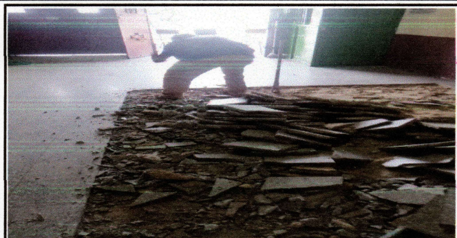
reparacion de piso en entrada
