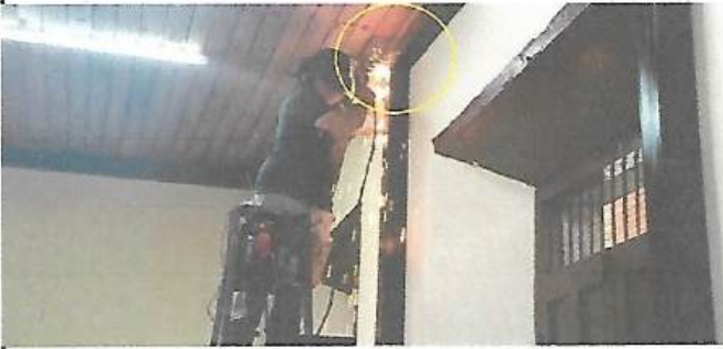
Instalación de los andamios metalicos, soldadura electrica y esquineros.
