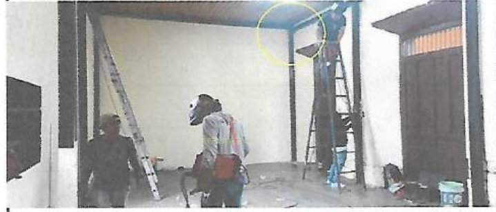
Andamio metalico, soldadura electrica, colocación de esquineros para reforzamiento.
