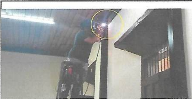
2 Andamio Metalico, soldadura eléctrica, esquineros
