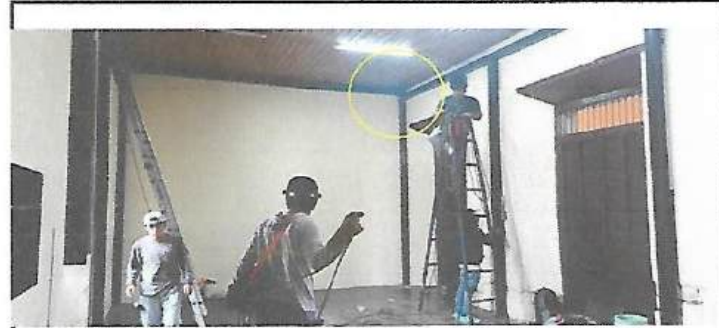
Colocación del Andamio metalico adosado a las paredes y esquinas.
