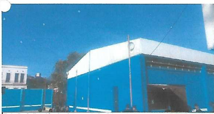
Foto 5: Aplicación de pintura exterior latex
