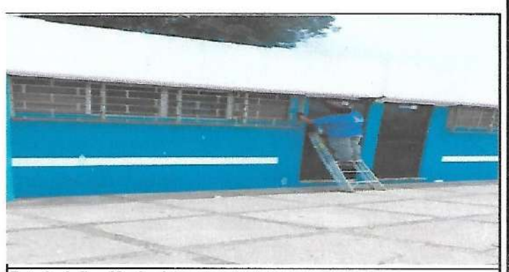
Foto 6: Aplicación de pintura exterior latex
