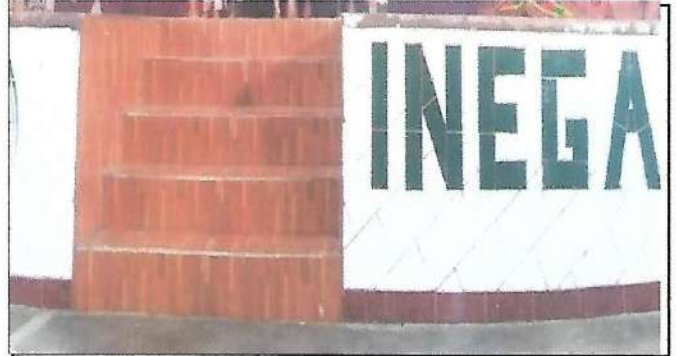
Foto 2: Sustrucción de azulejo en escenario salón de usos múltiples
