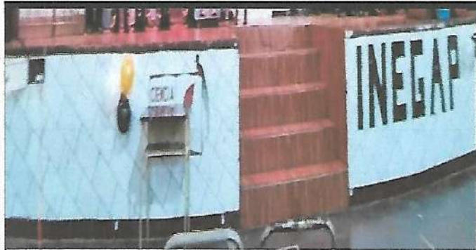
Foto 1: Sustrucción de azulejo en escenario salón de usos múltiples
