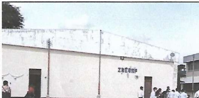
Foto 5: Aplicación de pintura exterior latex
