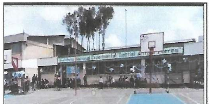
Foto 6: Aplicación de pintura exterior latex
