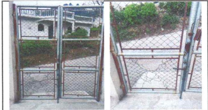
Fabricación de portón principal con tubo proceso de 1 1/2, chapa 16, más lámina de 1/32
