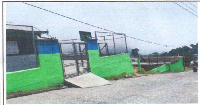
Cortado de pared por ampliación de portón más fundición de rampa de acceso y marco sobre el portón.
