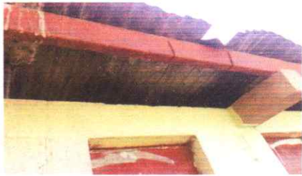
Sustitucion de lamina acanalada
