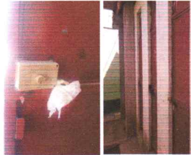
Mantenimiento de puertas metalicas
