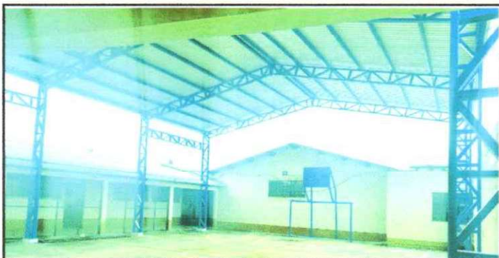
Foto 5: Vista del fondo de la cancha con el techado terminado.
