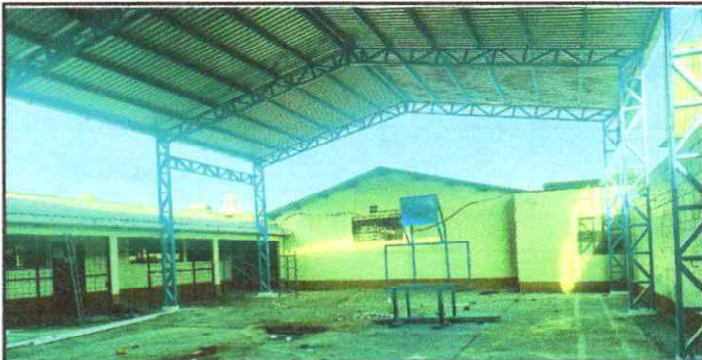
Foto 5: Colocación de techo general de toda la cancha
