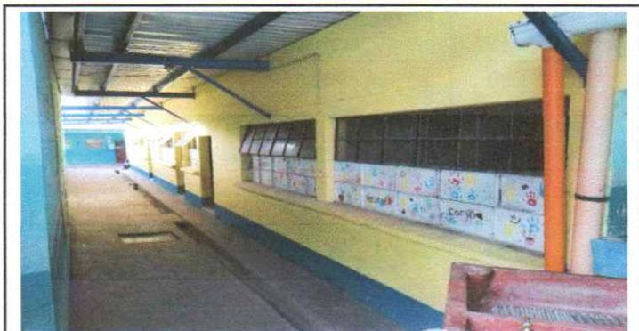
Sustitución de ventanas de metal por ventanas de upvc. ( Para tener mejor ventilacion en aulas con mucho calos. Ventas abriran en dos hojas corredizo.)
