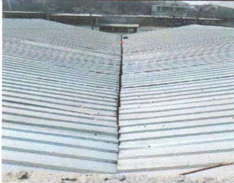
Cambio de canal pluvial de pvc por canal galvanizado que recepciona dos caídas de agua . ( es necesario levantar 224 m2 de lamina troquelada para hacer el cambio y mejoras dado que esta mal instalado y presenta mucha fuga de agua pluvial.)
