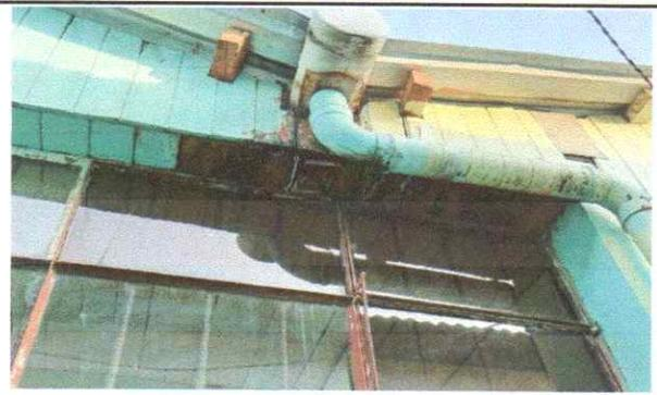
Cambio de canal pluvial de pvc por canal galvanizado que recepciona dos caídas de agua . ( es necesario levantar 224 m2 de lamina troquelada para hacer el cambio y mejoras dado que esta mal instalado y presenta mucha fuga de agua pluvial.)
