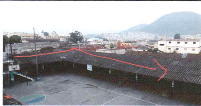
Sustitución de cubierta de duralita por de lamina acanalada
