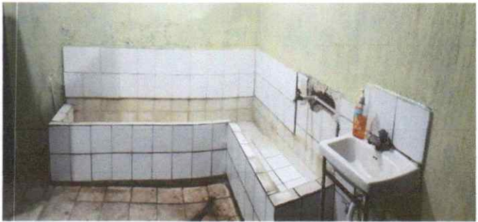
Mantenimiento de sanitarios con azulejo
