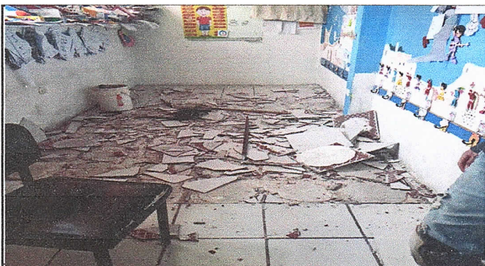
Sustitución de piso en corredores y aulas
