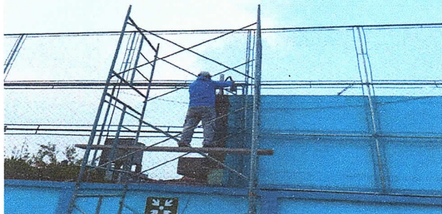
Sustitución de malla metálica con tubo galvanizado
