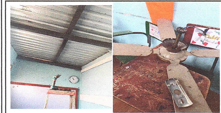
Sustitución de ventiladores
