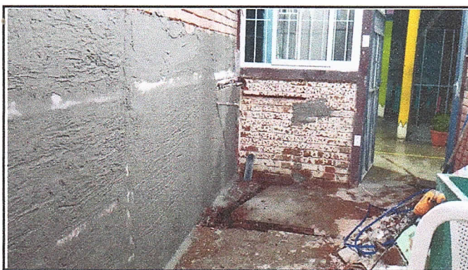
Suministro e instalación de pila
