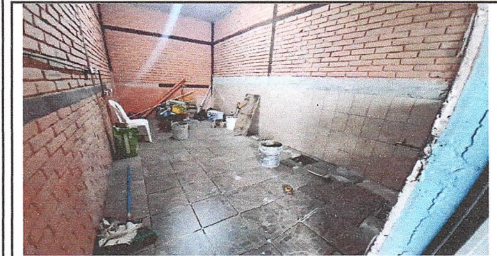
Mantenimiento de cocina
