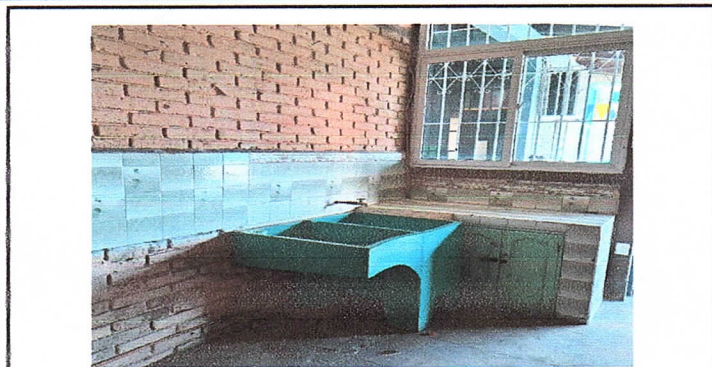
Mantenimiento de cocina
