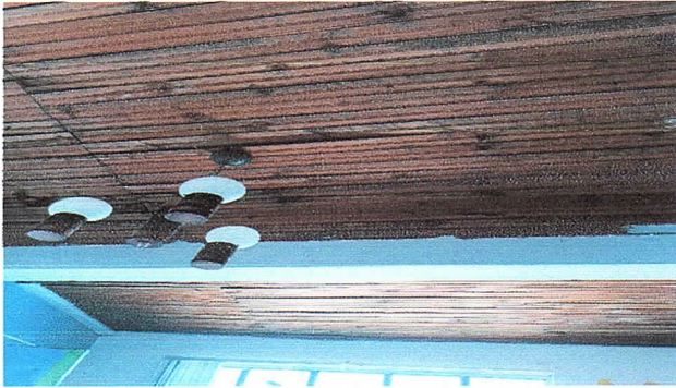
Instalación de cielo falso de PVC
