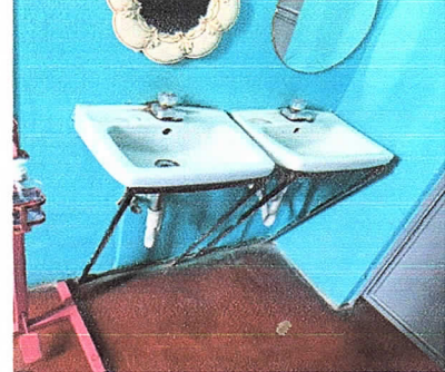
Sustitucion de lavamanos y mesas soporte
