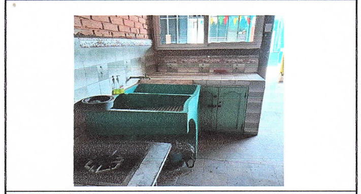
Suministro e instalación de pila
