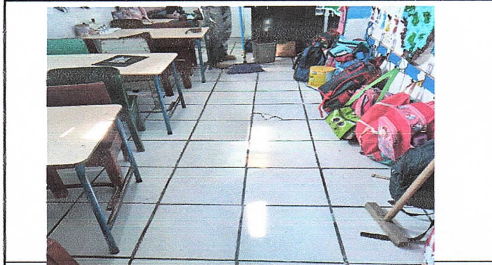
Sustitución de piso en corredores y aulas
