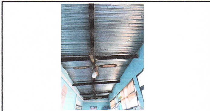
Mantenimiento de estructura de madera de soporte de techo
