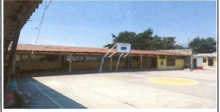
SUMINISTRO E INSTALACION DE LAMINA CALIBRE 26 MODULO 2
