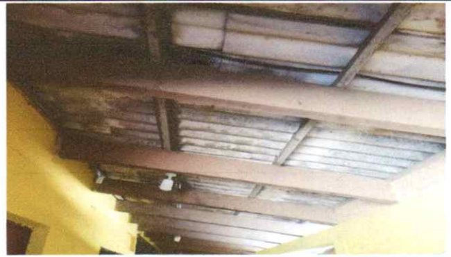
SUMINISTRO E INSTALACION DE TENDALES EN CORREDOR MODULO 3
