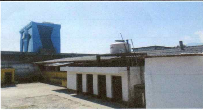
SUMINISTRO E INSTALACION DE LAMINA CALIBRE 26 MODULO 3
