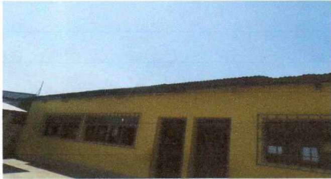
SUMINISTRO E INSTALACION DE LAMINA CALIBRE 26 MODULO 1
