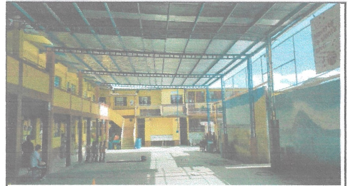
Sustitución de lámina por lámina troquelada calibre 26
