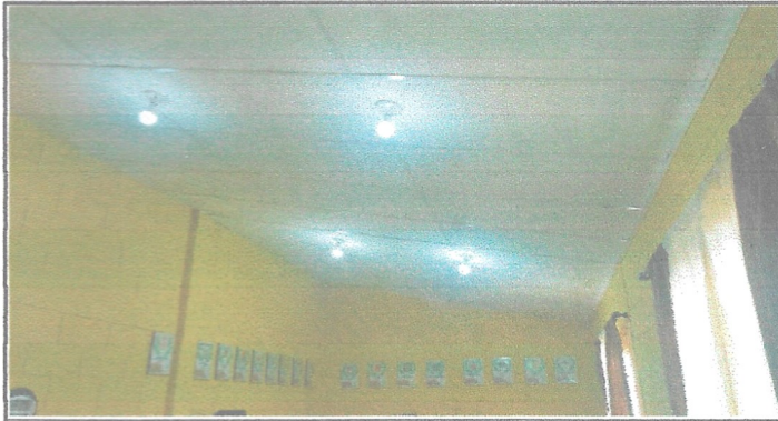
Sustitución de cielo falso reticulado
