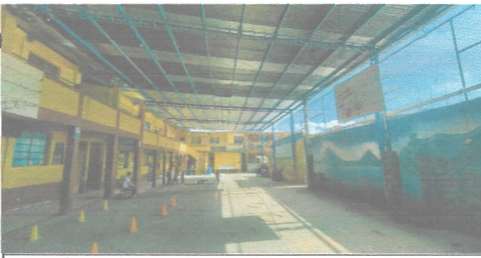
Sustitución de columna metálica de angular de 2"x1/8"
