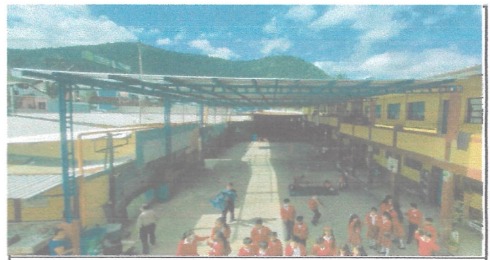
Sustitución de lámina por lámina troquelada calibre 26
