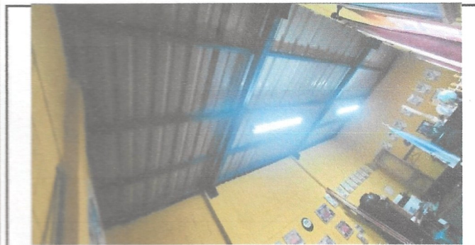
Sustitución de cielo falso reticulado
