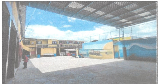
Sustitución de lámina por lámina troquelada calibre 26
