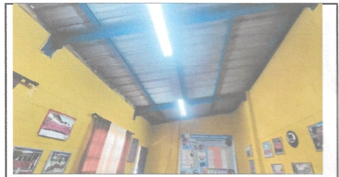
Sustitución de cielo falso reticulado
