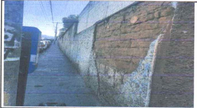
sustitucion de repello muro perimetral exterior
