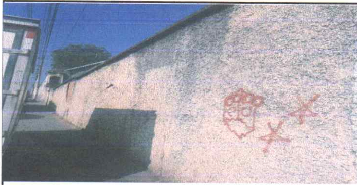
Sustitucion repello muro perimetral exterior
