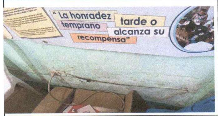
Preparación de sustrato para aplicación de impermeabilizante cementicio en muro (desbaste mecánico).
