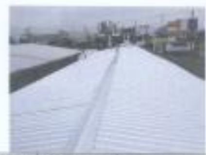
Foto 5: SUSTITUCIÓN DE TECHO DE LÁMINA AZUL
