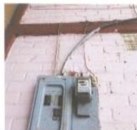
Sustitución de tendido eléctrico de todos los módulos y cajas de filipones.
