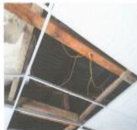
Sustitución de láminas módulo 2 y tendido eléctrico
