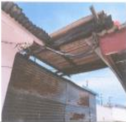
Sustitución de láminas módulo 3
