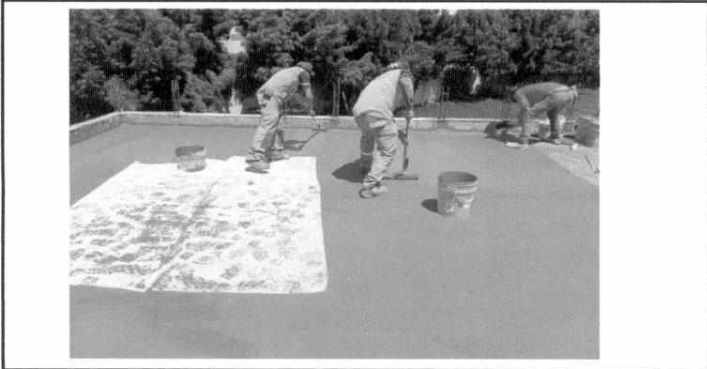
FOTO 3: APLICACIÓN DE IMPERMIABILIZANTE INDUSTRIAL EN LOSA
