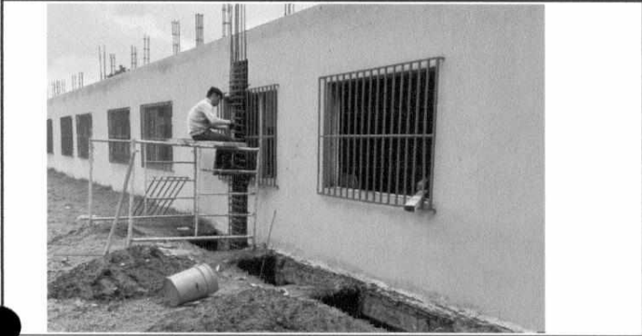
FOTO 1: INSTALACIÓN DE ZAPATAS Y COLUMNAS
