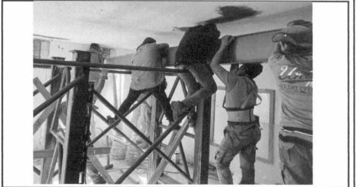
FOTO 2: INSTALACIÓN DE METAL
