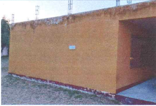
SUMINISTRO E INSTALACIÓN DE ZAPATAS
