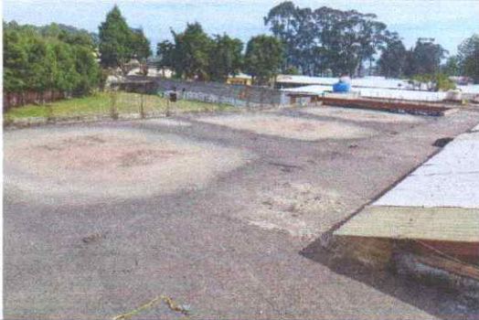
SUMINISTRO E INSTALACIÓN DE METAL
