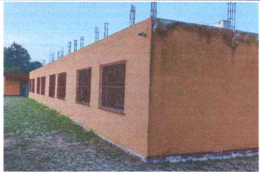
MANTENIMIENTO DE PISOS DE CONCRETO CON BANQUETA
