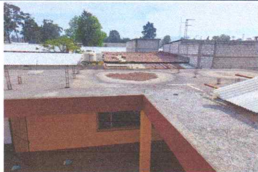
SUMINISTRO E INSTALACIÓN DE COLUMNAS
