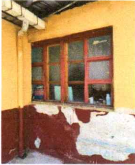
Sustitución de ventanas de metal por PVC
