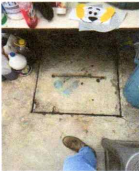
Suministro e instalación de cisterna de 2,500 litros de agua potable
