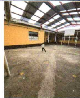
Sustitución de torta de concreto de cancha polideportiva
