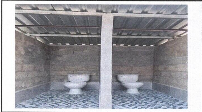
Foto7: sustitucion de baños, pegado de ceramica, repello y pintado
