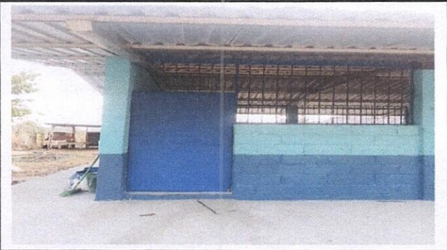
Foto 2: sustitucion de puertas del salon de clases
