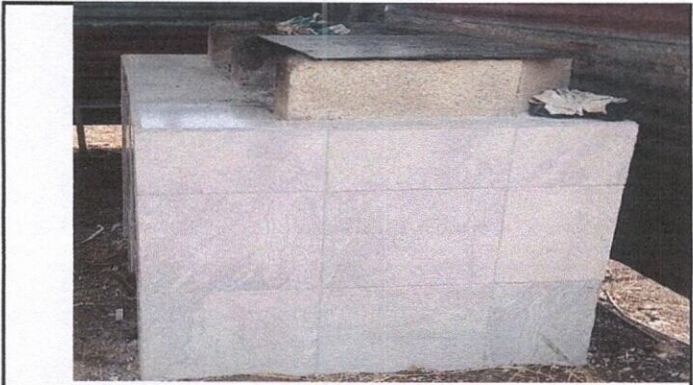
Foto 8: reparación de polleton y pegado de ceramica.
