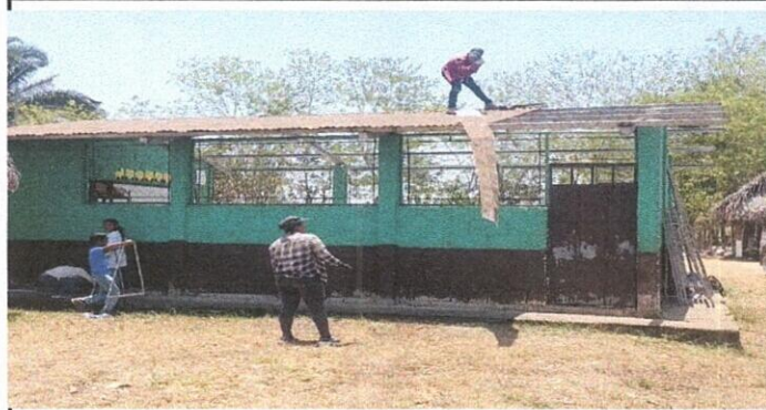
Foto1: sustitucion techo de metal por de metal y pintura en paredes
