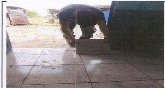
Foto 4: sustitucion de piso de concreto por piso ceramico
