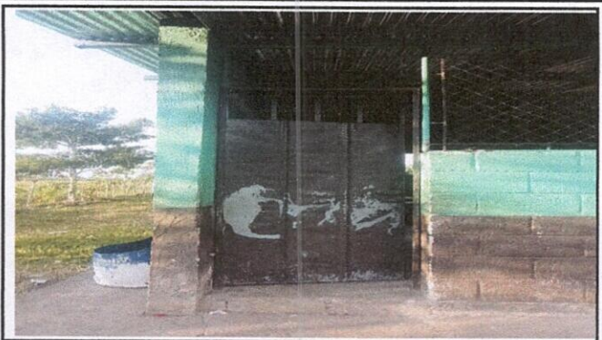
Foto 2: sustitucion de puertas del salon de clases
