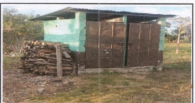
Foto 6: sustitucion de puertas de baños, sustitucion de techo y pintado en baños.
