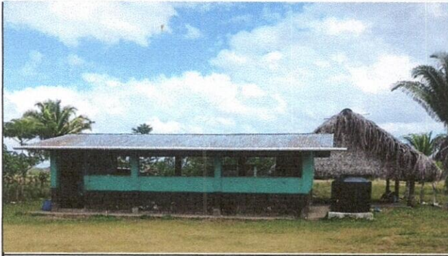
Foto1: sustitucion techo de metal por de metal y pintura en paredes
