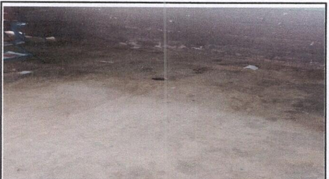
Foto 4: sustitucion de piso de concreto por piso ceramico
