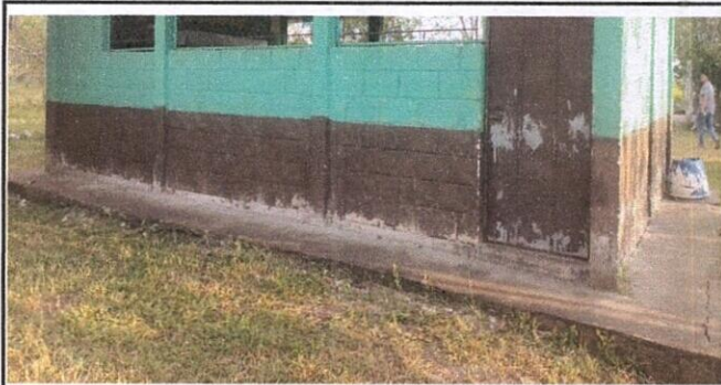
Foto 3: reparacion de banqueta de concreto
