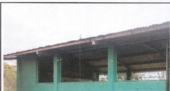
Foto 5: sustitucion de balcones de maya, por de metal
