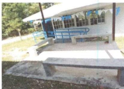
Foto 3: Sustitución de piso de torta de concreto ✓
